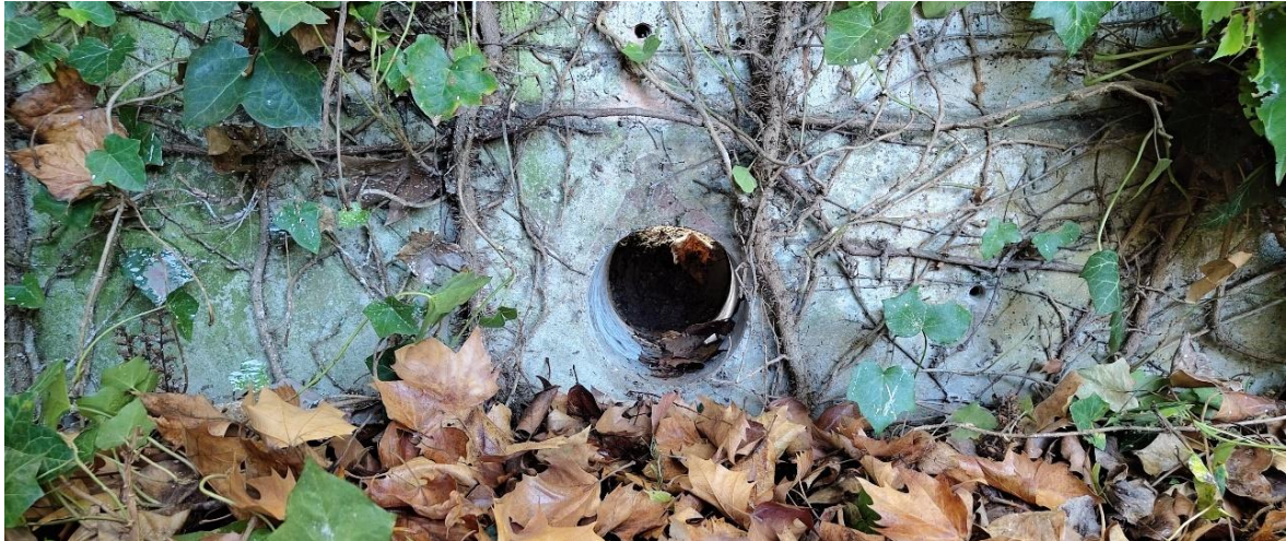
Abb. 14: Kernbohrloch in der Mauer des Friedhofs Wolfgottesacker in der Stadt Basel. Kernbohrungen in Mauern schaffen wirkungsvolle Durchgänge für kleine Wildtiere. Sie müssen von spezialisierten Firmen ausgeführt werden (© Julia Felber / wildenachbarn.ch).
