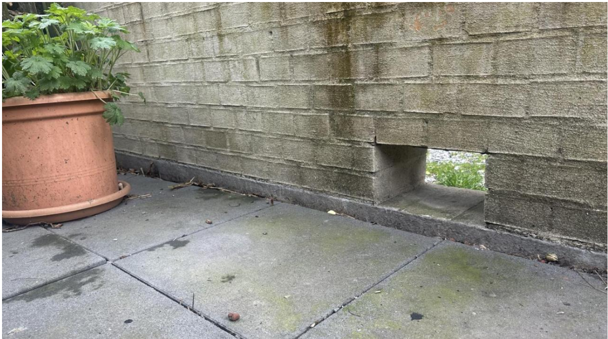
Abb. 24: Durchgang in einer Mauer, der dank einer aufmerksamen Anwohnerin und einer sensibilisierten Hauseigentümerschaft bereits beim Bau der Mauer eingebaut wurde (© Helena / stadtwildtiere.ch).
