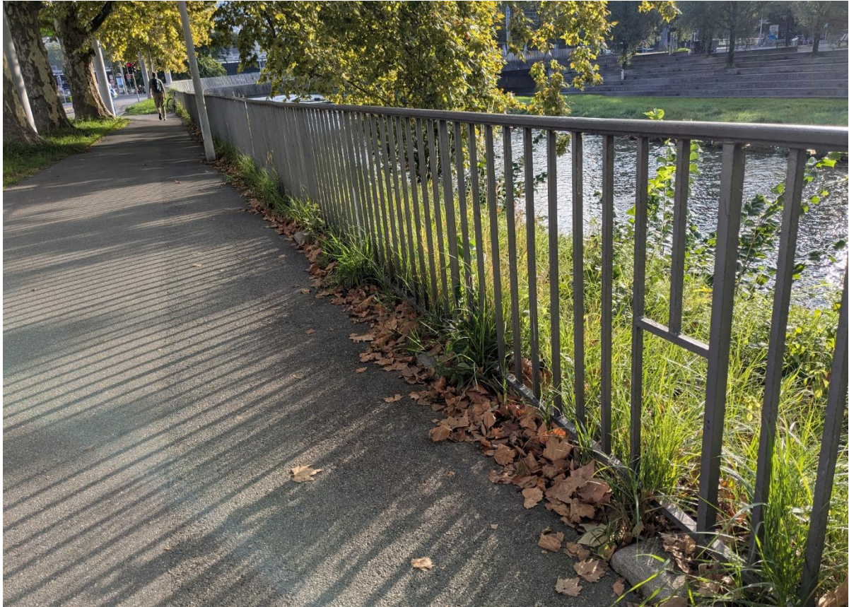
Abb. 23: Ein Durchgang in einem Metallzaun, der bereits bei der Erstellung des Zauns eingeplant war und sich rund alle 20 Meter wiederholt (© Sandra Gloor / stadtwildtiere.ch).
