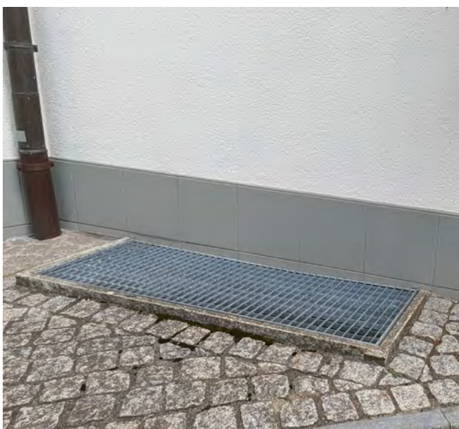
Vergittertes Oberlicht © wildenachbarn.ch
