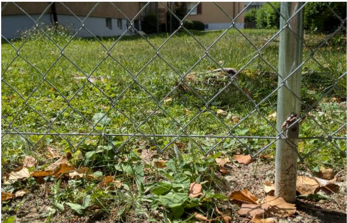
Abb. 23: Wenn Zäune bereits 10 cm über dem Boden enden, lassen sie genügend Raum für kleine Wildtiere, dass sie auf die Grünfläche gelangen können (© Sandra Gloor / stadtwildtiere.ch).
