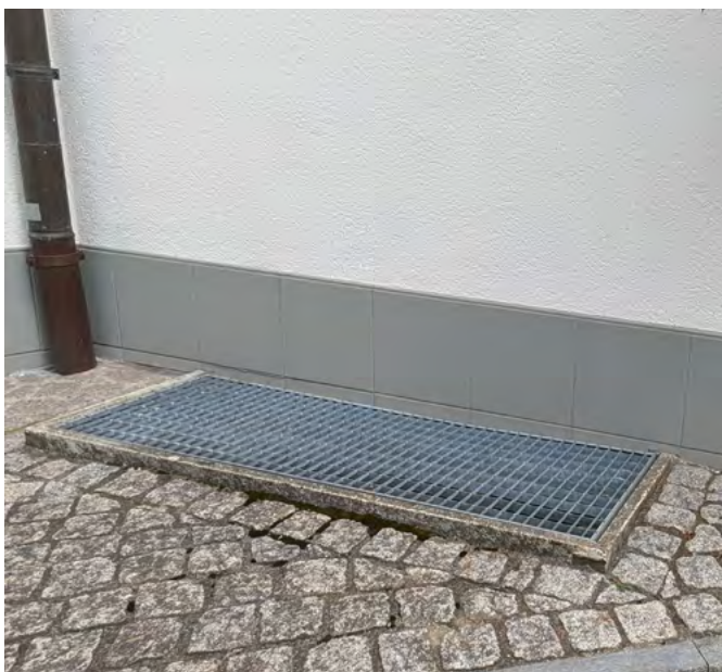
Vergittertes Oberlicht © wildenachbarn.ch
